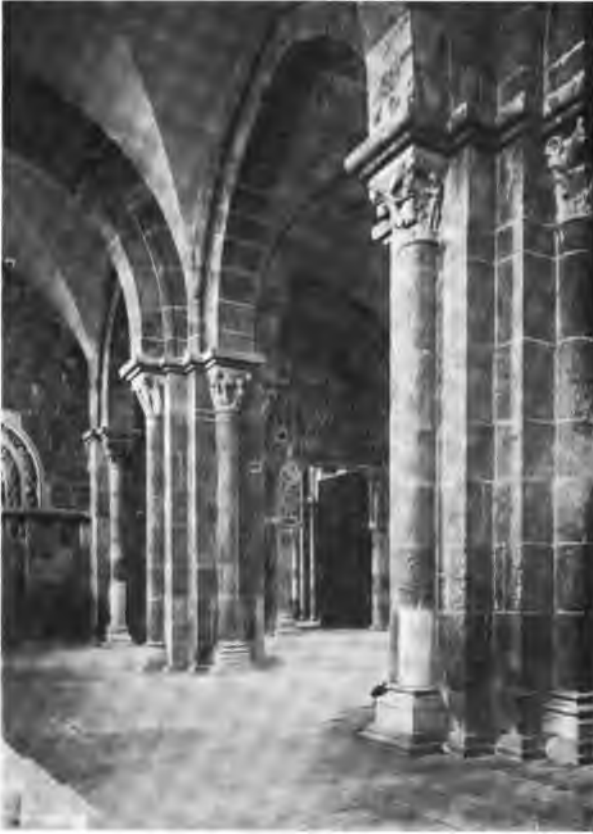
Fig. 43. — Piliers cantonnés de colonnes au narthex de l'église de la Madeleine de Vézelay, xiii e siècle.
